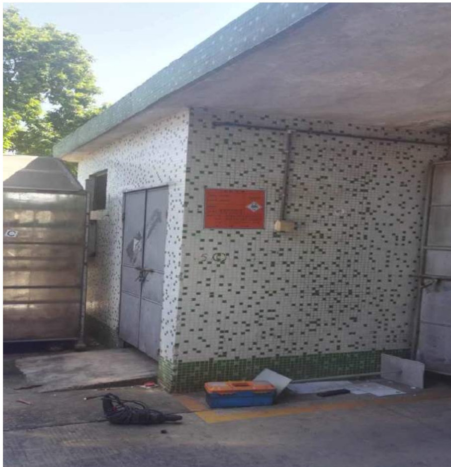
危险废物堆放点 01
